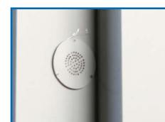
Válvula equilibradora de presión (congelación)
